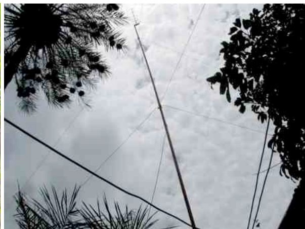
Die 18m hohe Antenne ist auf zwei Höhen je auf drei Seiten gesichert
