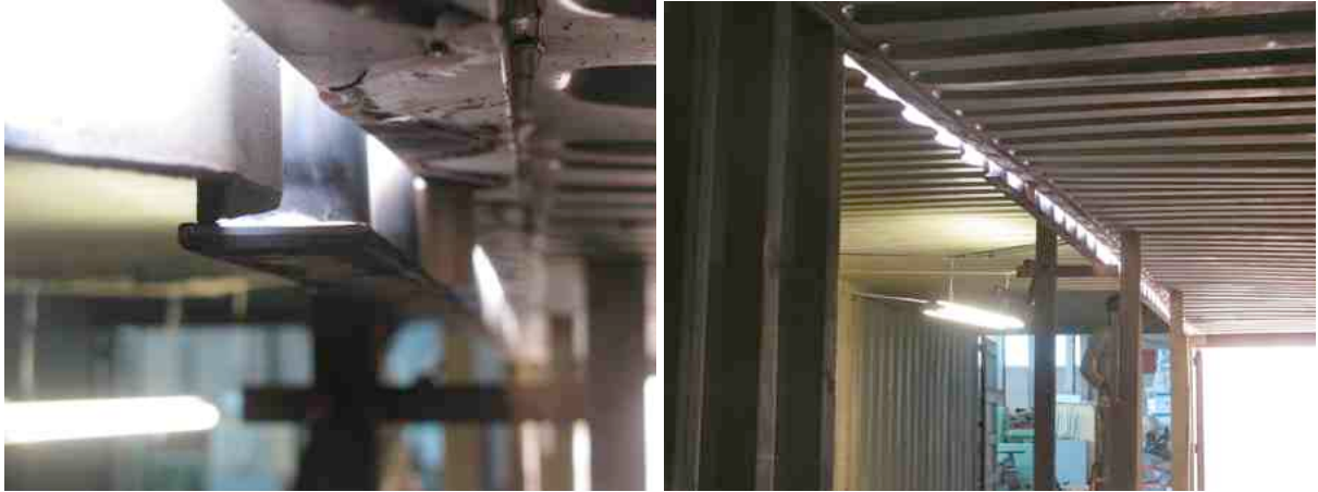
Bei der Verbindung vom Dach übernimmt ein Flacheisen „auf Zug“ das Gewicht der Decke
