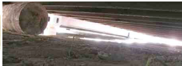
Ein Blick unter den roten Container während des Verschiebens, er rollt auf Palmier-Stücken
