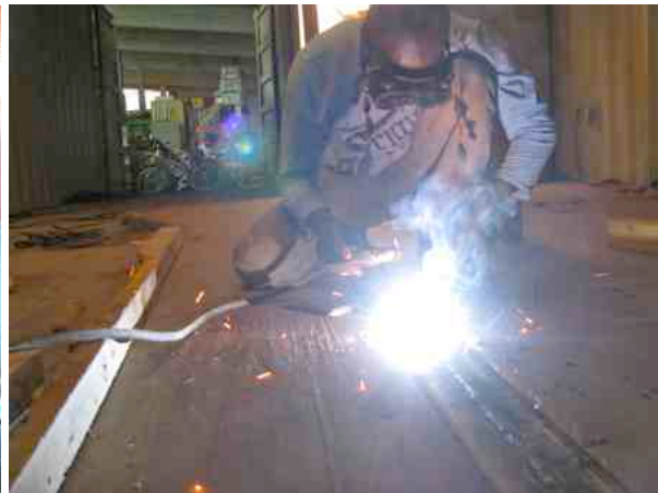
Sadio schweisst die Böden auf der Innenseite zusammen
