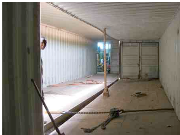
Zum Schluss ziehen wir die beiden von der Innenseite noch ganz zusammen
