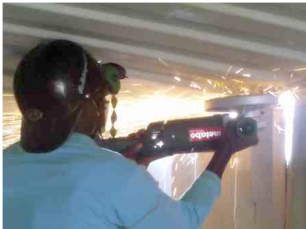
Mit der Trennscheibe schneidet Sadio die 2mm starken Seiten entlang der Schweissnaht durch
