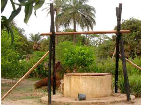
Hier ist der Balken noch nicht abgestützt
