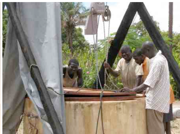
Von oben ziehen wir den Aushub aus dem Brunnen
