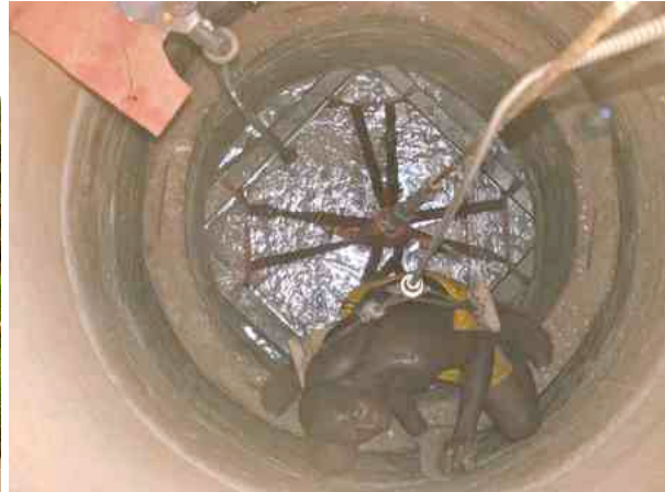
Omar spitzt den Zement zwischen den Rohren weg
