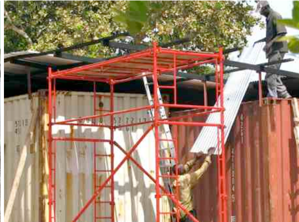
Bei der Montage der Dachbleche kommt das Gerüst zum Einsatz
