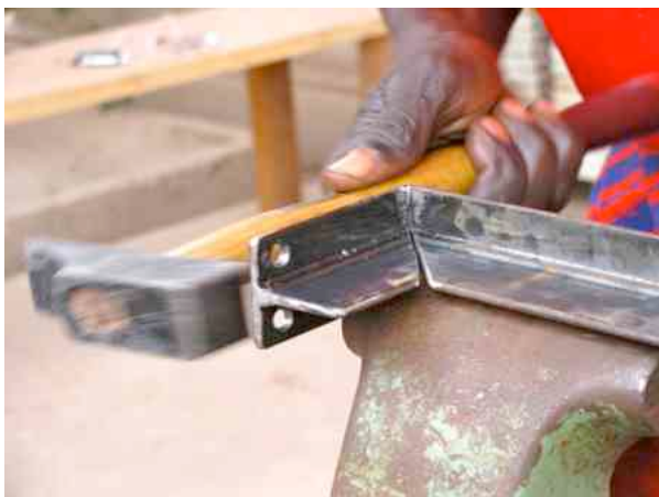
Fertigung der Stützen im Atelier
