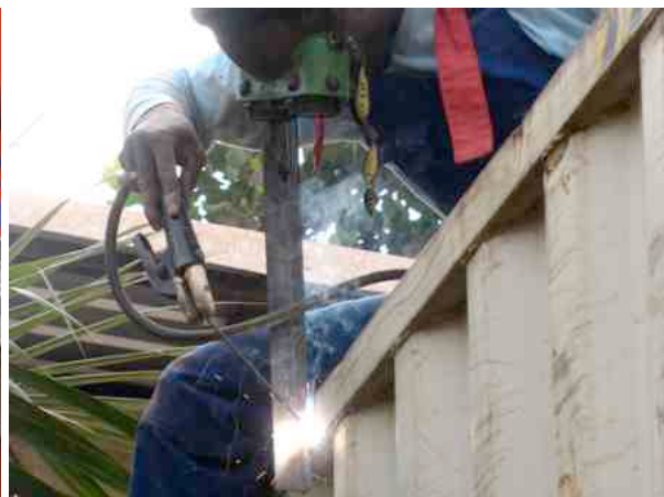
Montage der Stützen an den Containern
