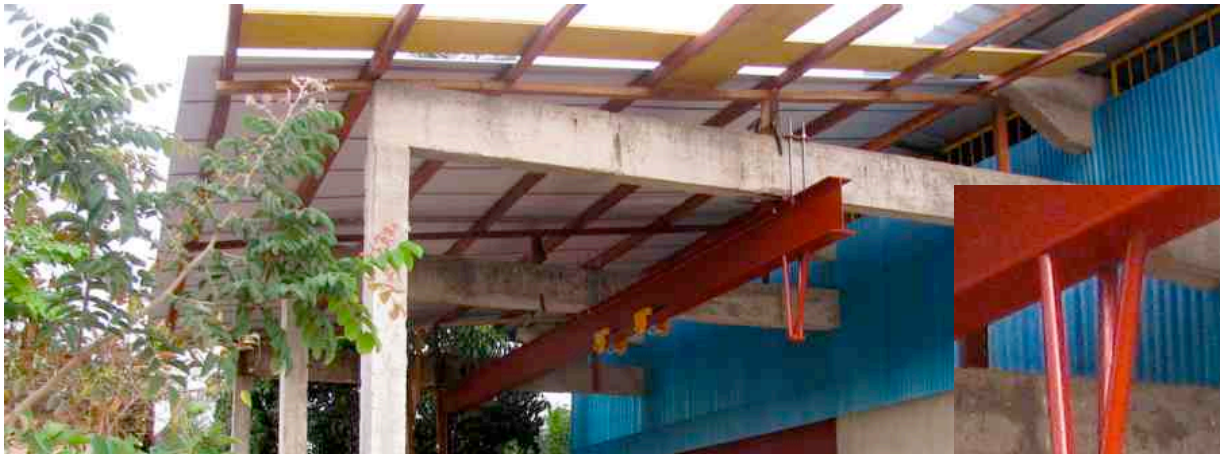
Hier fehlt am Dach nur noch eine Reihe Bleche
